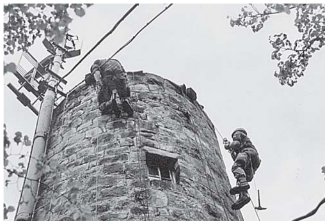
Reparaturarbeiten im Mai 2005.
