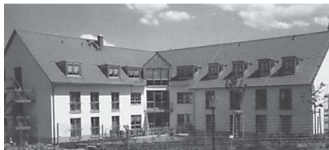
Neubau in Reinsdorf an der Wiesenaue.
