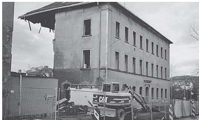
Abriss des ehemaligen Amtsgerichtes und Arresthauses,
